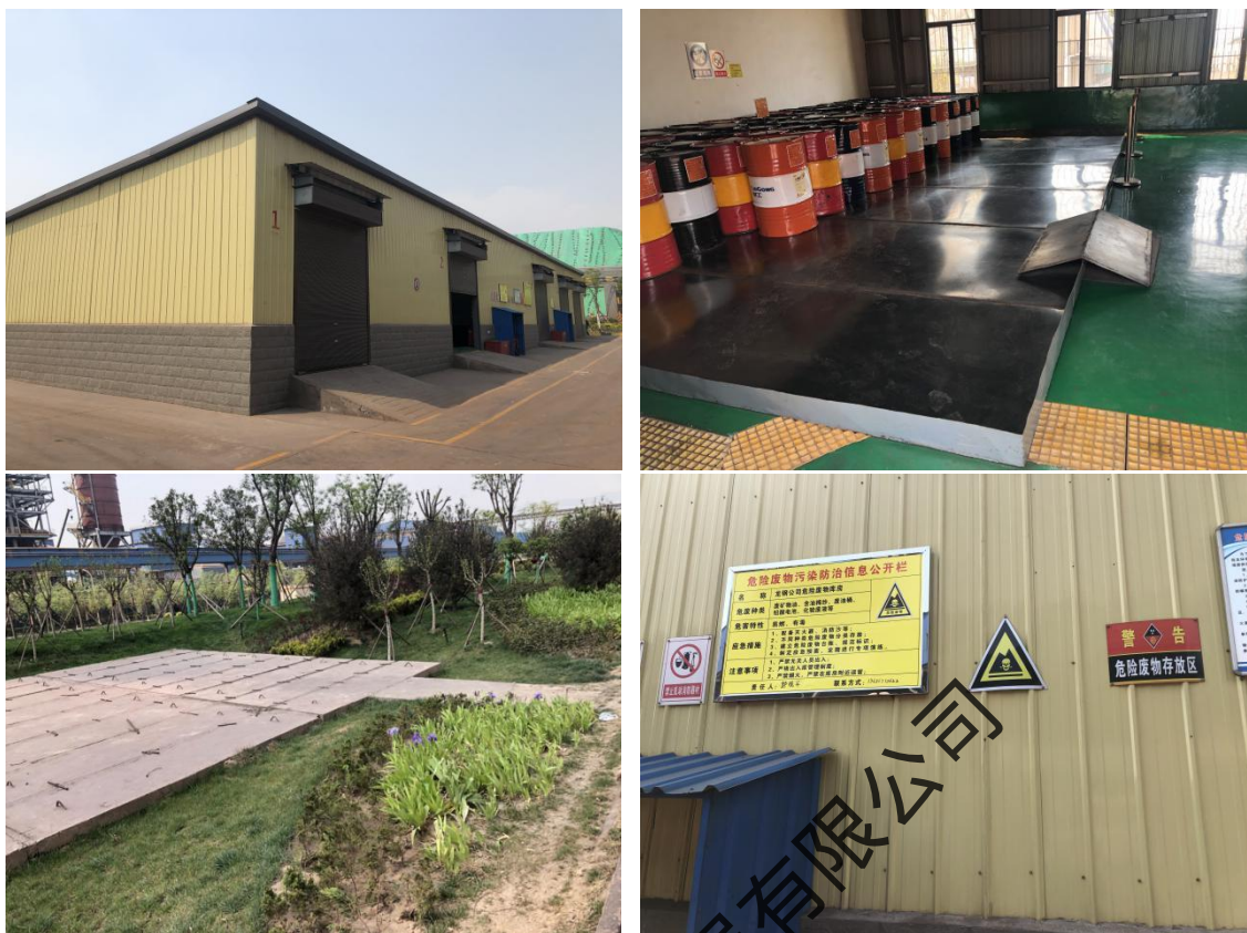
图8.3-1 危险废物临时储存场所建设情况
